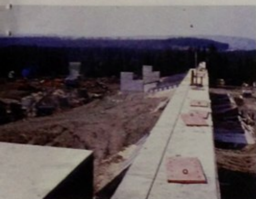
Bauarbeiten in Rittersdorf im Herbst 1961 Garld & Janice Edwards
